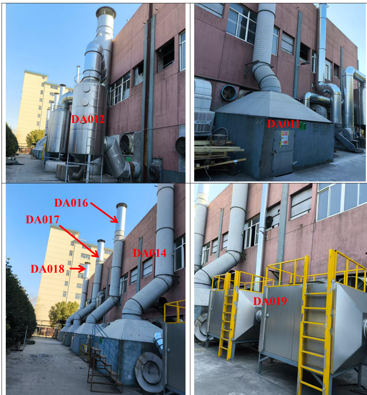
图 4-4 废气处理装置图
